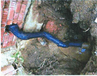
Figura 4. Sanimi i gypit furnizues nga ujisjellësi te zbutsat e vjeter në NO
