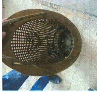
Figura 2. Mirëmbajtja e filterave para pompave qarkulluese të trjetjes së distribuimit.
