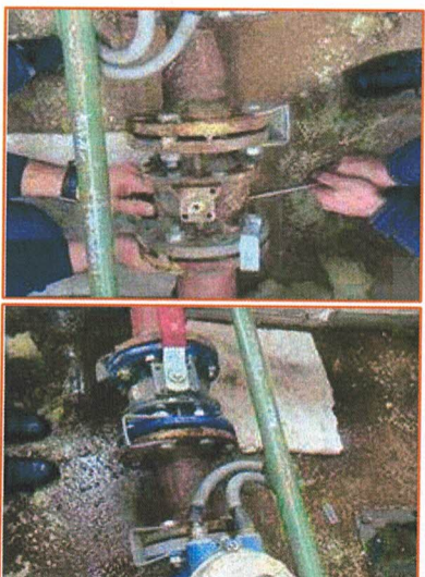
Figura 8. Ndërimi i valvës DN 125 e cila ishte në defekt, Check valve të paisja për mbajtje të presionit në rrjet të kogjenierimit.
