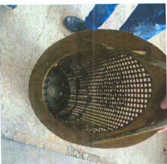
Figura 2. Mirembajtja e filterave para pompave qarkulluese të rrjetës së distribuimit.
