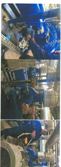
Figura 7. Lubrifikimi i pompave dhe elektromotore: NQ, HRS, HES dhe stacion BD.
